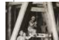
Storie di tunnel
