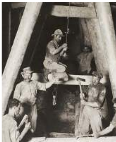
Les travaux dans le tunnel de base du Hauenstein vers 1912.
