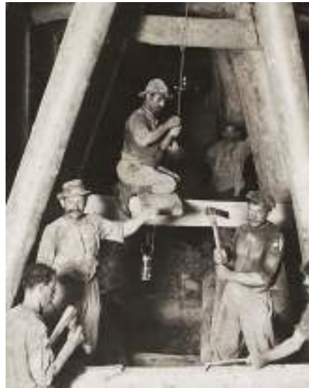
Arbeiten im Hauenstein-Basistunnel um 1912.
